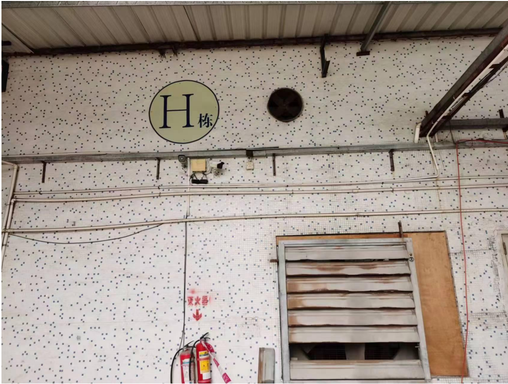
***有限公司H栋注塑部厂房
