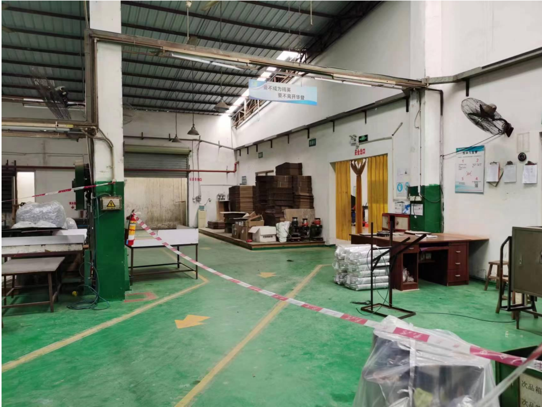
H栋注塑部厂房地面（屋顶距离地面约5米）
