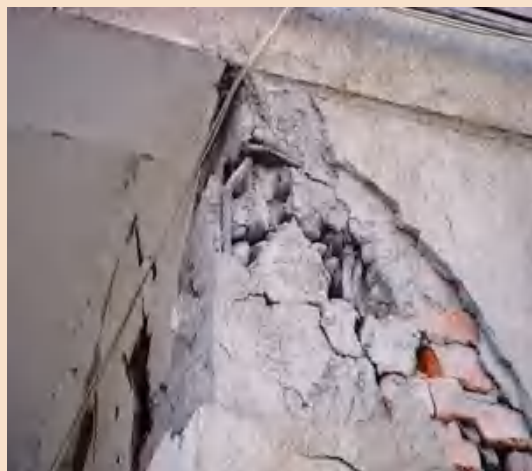
支承梁下墙体出现宽度超过 1mm 的裂缝
