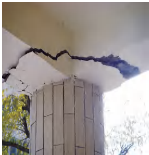
柱端部压裂
