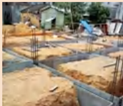
混凝土条形基础
