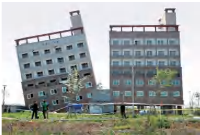
沉降不均匀引起房屋倾斜
